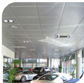
Des systèmes standards adaptables à tous type de projets de plafond : les cassettes se posent sur ossature T et se démontent facilement par simple soulèvement.
